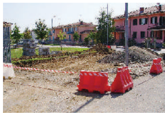
Cantiere in piazza Divisione Alpina Cuneense
